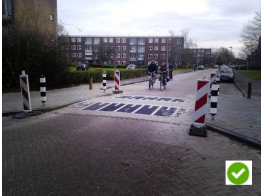
Foto: Wegversmalling elders in het land waarbij reflectie is toegepast om de verhoging in het donker te zien.
