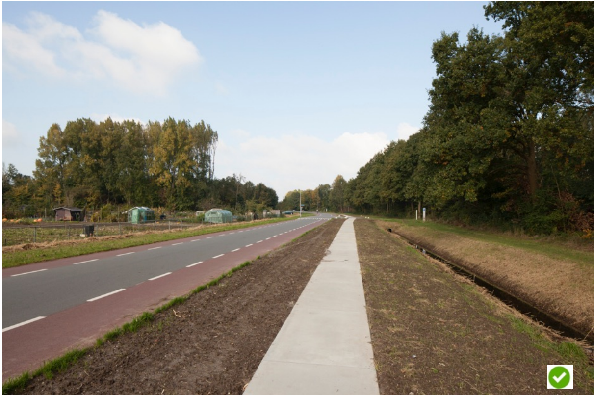
Foto: Bosweg in Swifterbant. Het losliggende pad is van beton en daarmee lichter van kleur (zolang het wegdek droog is). Het fietspad op de weg is roodgekleurd om een goed contrast te krijgen. Je kan dit wegdek ook in het donker laten reflecteren door een toeslagmateriaal erdoor te doen.
