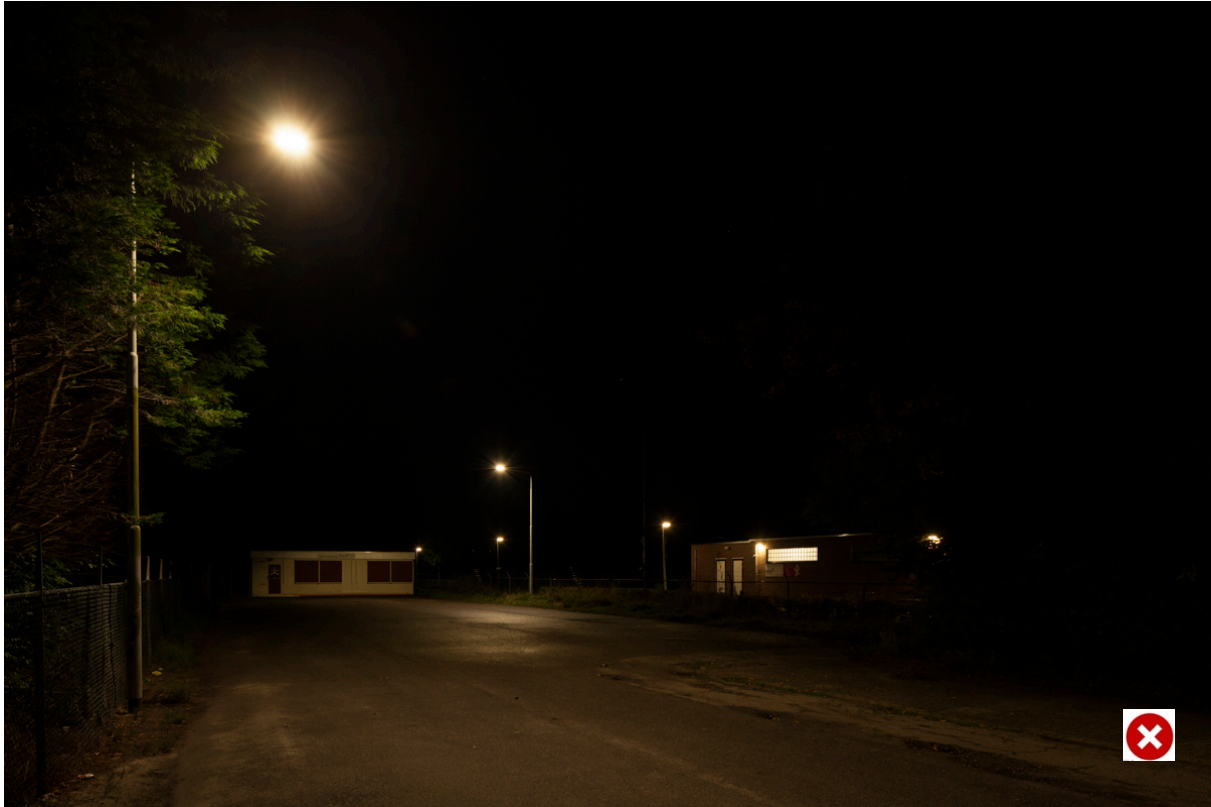
Foto: Parkeerplaats bij de tennis en voetbalvereniging in Swifterbant; Verlichting op parkeerplaats. Dit is tijdens het sporten wenselijk maar na de sluiting, als het terrein helemaal leeg is, kan het licht uit.
